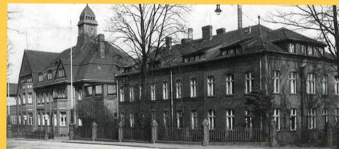
Hauptverwaltung der Ilse Bergbau AG in Großräschen
